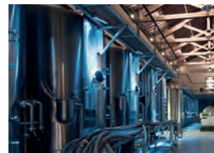
REFRIGERAÇÃO DE PROCESSO
